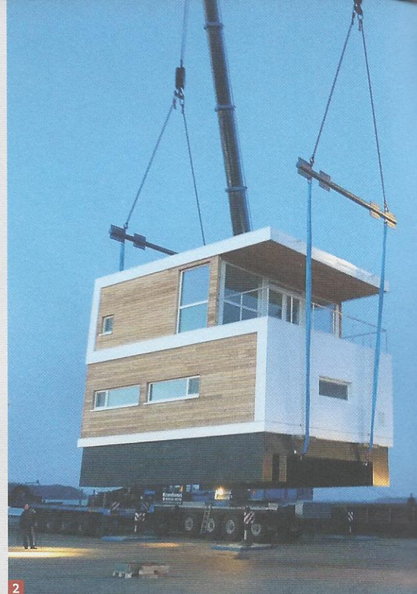
1 Die Grundrisse erinnern in ihrer Kompaktheit an Einfamilienhäuser. 2 Die erste Serie des Typs floating100 wurde komplett vorgefertigt und mittels Kran auf die Schwimmkörper (Pontons) gestellt.
